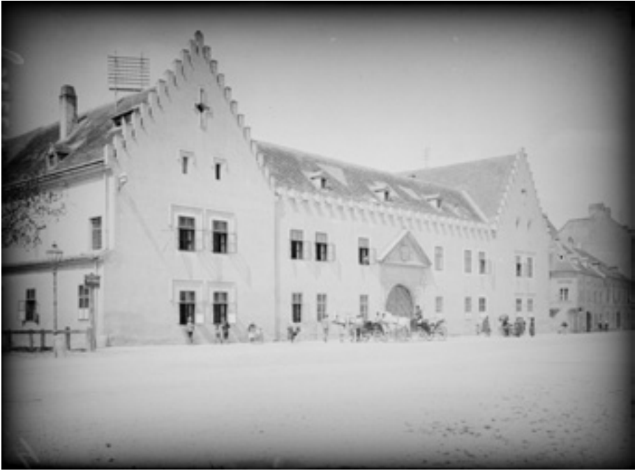
Abbildung 7: Zeughaus Wiener Neustadt, Fassadenansicht von links mit Renaissancetor, undatiertes Foto eines unbekanntenen Fotografen aus dem 19. Jahrhundert (anlässlich eines Besuchs einer hochgestellten Persönlichkeit aufgenommen) (ÖNB, BA).
