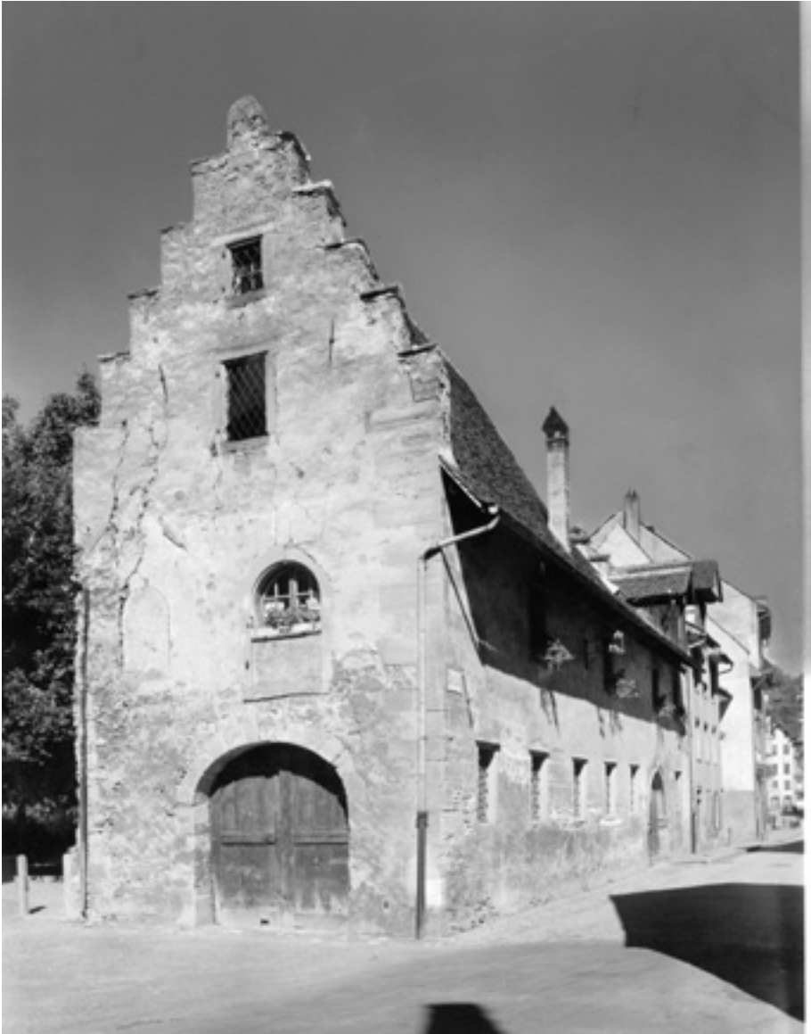
Abbildung 3: Das 1436 nachweisbare, ehemalige Bürgerliche Zeughaus in Feldkirch (Vorstadt Nr. 48) mit breitem Rundbogenportal mit Kämpfern und Archivolten in einer klaren Renaissanceform. Am Scheitel des Zeughauses befindet sich das Feldkircher Wappen. Im Erdgeschoss und im ersten Stock zeigen sich hochrechteckige Fenster mit gotischer, profilierter Verdachung. Im Inneren des Feldkircher Zeughauses findet sich eine Holzdecke und eine Mauerbank auf Steinkonsolen (ÖNB, BA).
