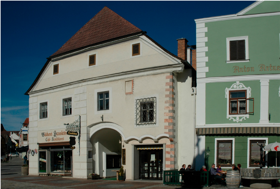
Abbildung 1: Das Gebäude am Dreifaltigkeitsplatz 4 beheimatet heute die Bäckerei-Konditorei Hausleitner, Aufnahme von 2010, Stadtarchiv Zwettl, Foto: Werner Fröhlich.
